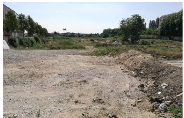
Fig. 2 / Site du futur Ecoquartier Coteaux-Beauclair ©MarcBarra
