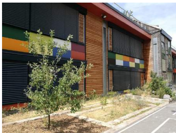
Fig. 8 /Vue depuis la cour intérieure de l'école maternelle des Boutours. ©MarcBarra
