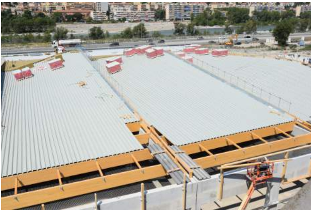
Fig. 7 / Travaux d'étanchéité de la future toiture végétalisée©Cerema
