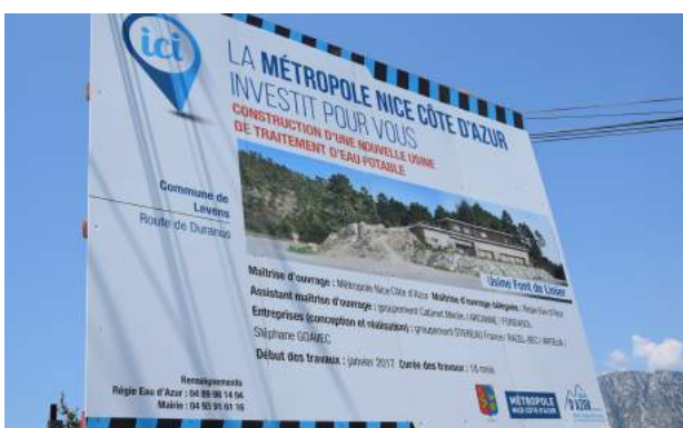
Fig. 18 / Panneau d'affichage des travaux©Cerema
