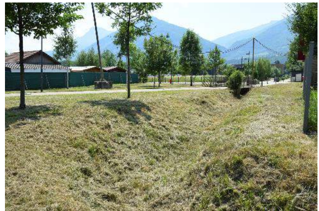
Fig. 9 / Gestion des eaux pluviales de l'espace public par des noues ©Cerema
