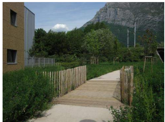
Fig. 7 / Le système de noues d'infiltration (passage de la noue sous la passerelle bois.) ©GAM
