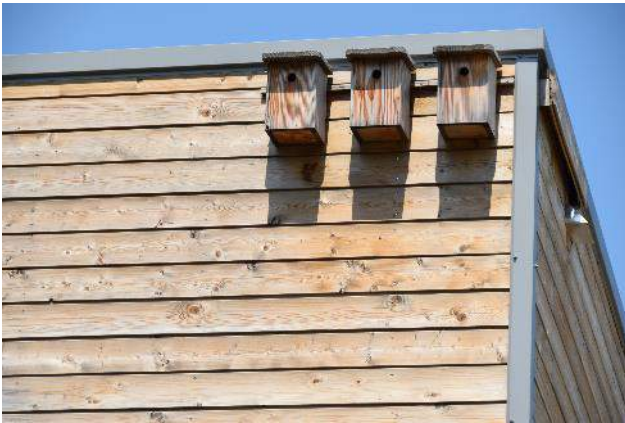
Fig. 5 / Nichoirs en façade © Cerema
