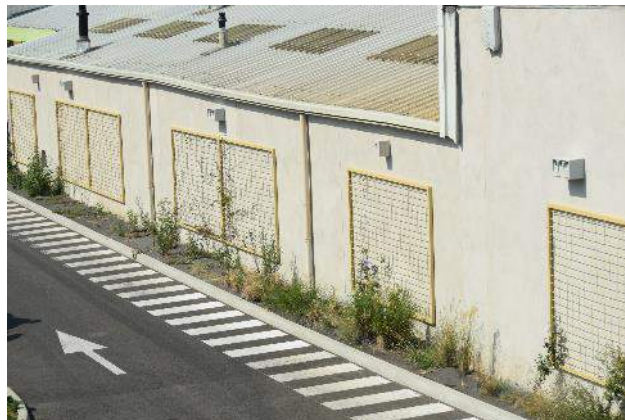
Fig. 11 / Nichoirs et plantes grimpantes en façade du centre technique@cerema
