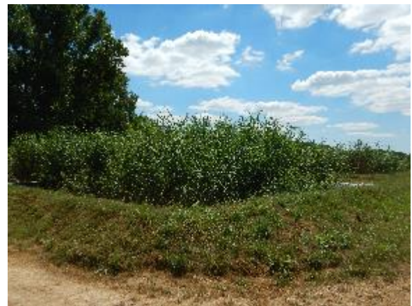
Figure 11. Filtrés plantés de roseaux ©Damien CARAT
