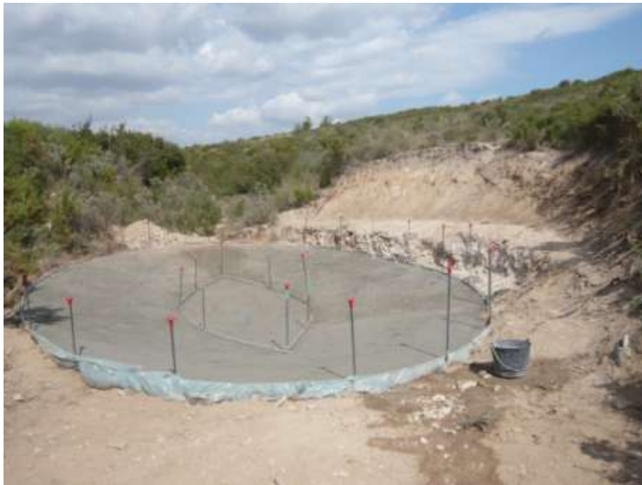
Figure 3 : La lavogne en cours de construction
