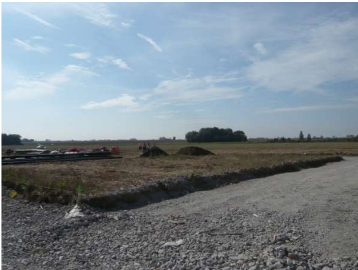
Figure 4 : Les travaux sur la zone maraichère de Wawrin
